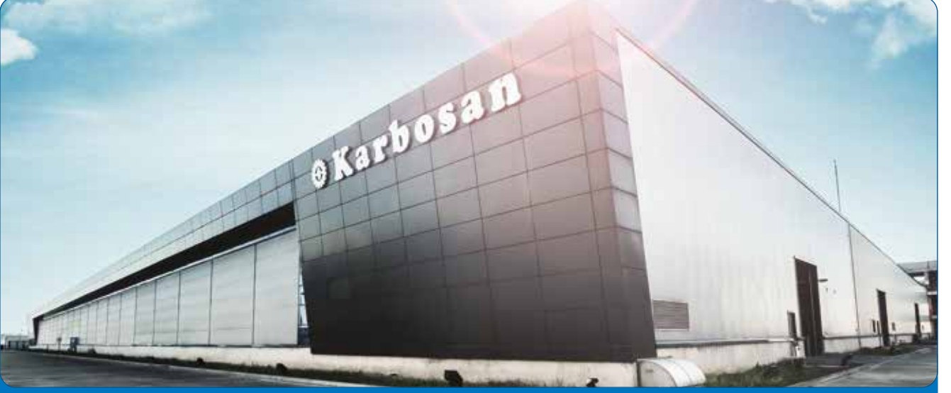
Karbosan Veliköy Fabrikası
